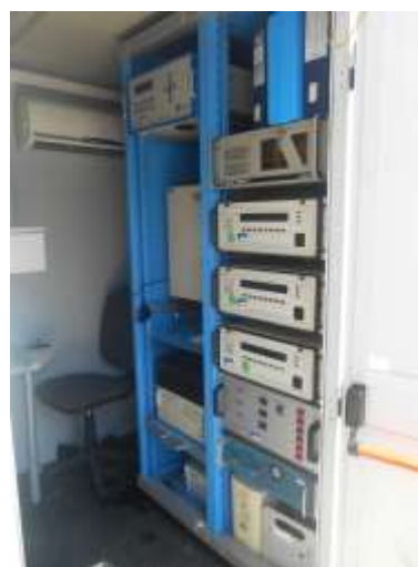
Figura 5 – Interno stazione di rilevamento della qualità dell'aria
